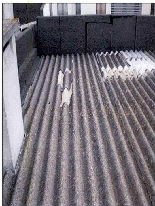
Figura 14 - Beco das Olarias– Telhas de Fibrocimento partidas
