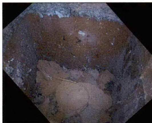
Figura 17- Rua Manuel de Oliveira – Obstrução da chaminé (vista de baixo e vista de cima)
