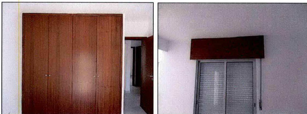
Figura 10- Substituição de frentes de armários e caixas de estores
