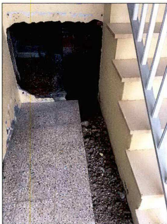
Figura 13- Beco das Olarias– Reparação de Ramais de Esgoto
