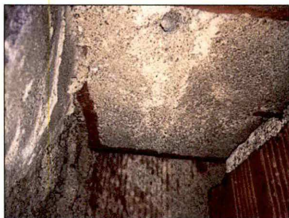
Figura 12- Rua Manuel de Oliveira – Obstrução da chaminé (vista de baixo e vista de cima)
