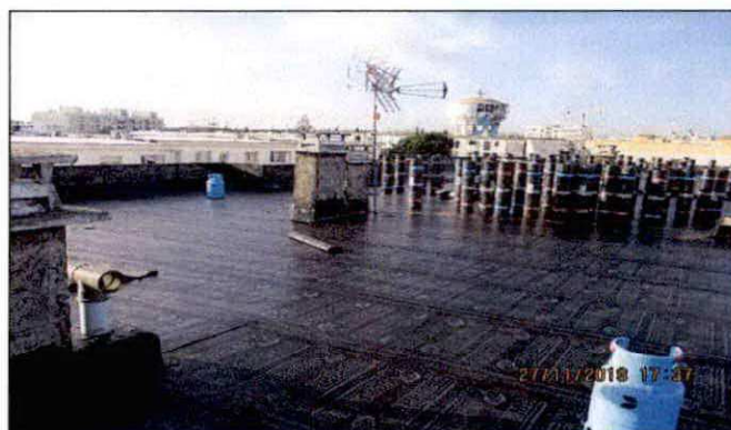
Figura 11 - Bairro Fundo de Fomento de Habitação-Colocação de telas betuminosas
