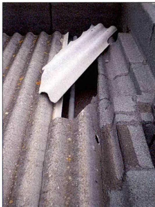
Figura 19 - Beco das Olarias– Telhas de Fibrocimento partidas
