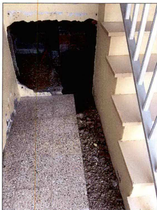
Figura 18- Beco das Olarias— Reparação de Ramais de Esgoto
