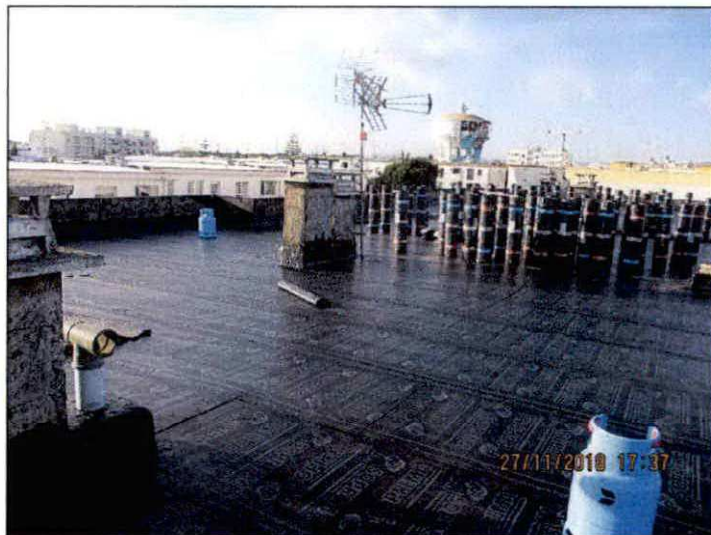
Figura 6 - Bairro Fundo de Fomento de Habitação-Colocação de telas betuminosas
