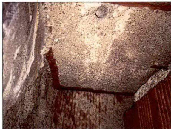
Figura 17- Rua Manuel de Oliveira – Obstrução da chaminé (vista de baixo e vista de cima)
