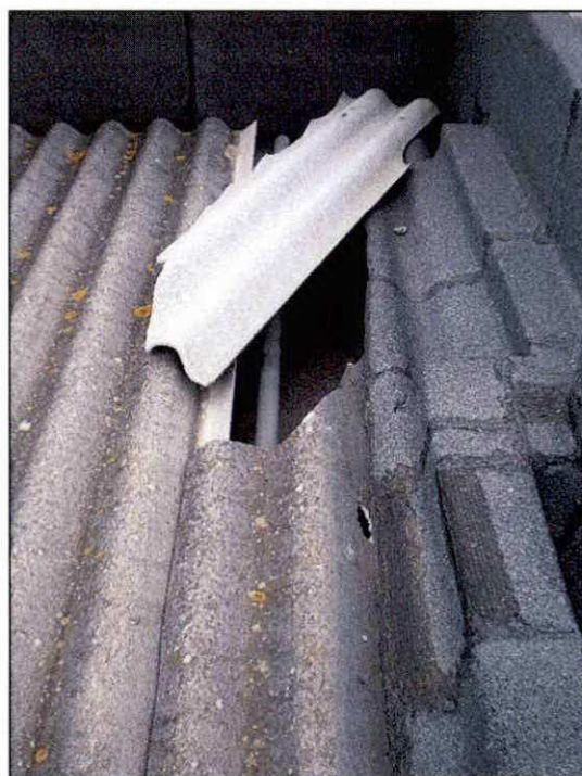
Figura 14 - Beco das Olarias– Telhas de Fibrocimento partidas
