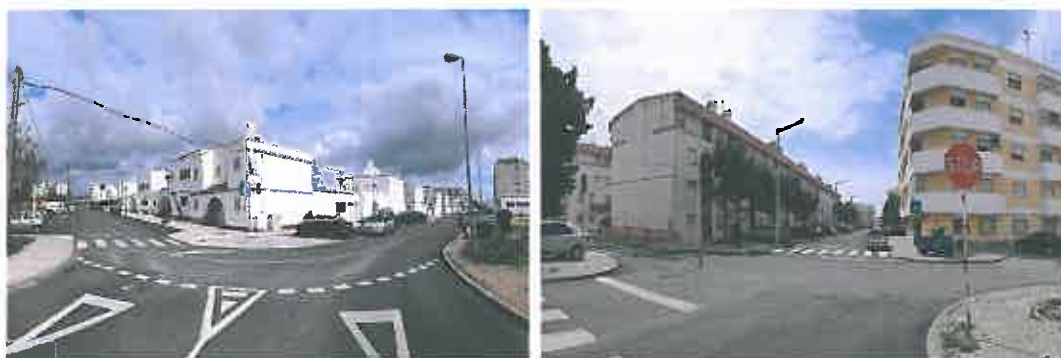
Pavimentações em arruamentos
