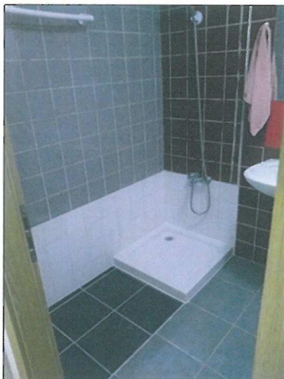
Figura 11 - Troca de banheira por base de duche - HAB 805, Rua da Armonia, Edifício 1, n.º2, 1.º dt.º
