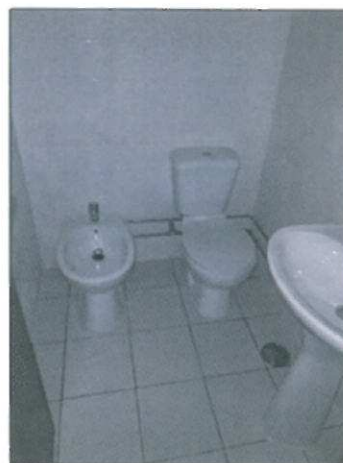
Figura 22 - HAB 620 – Rua Zulmira Lopes das Neves, nº9, r/c dt.º
