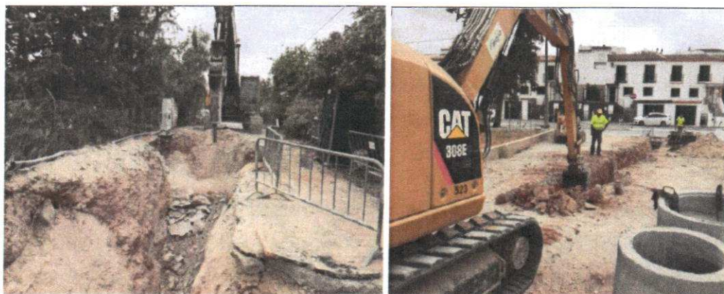
Figura: Obra de ampliação da rede de esgotos - Empreitada das “Redes de coletores domésticos associados ao sistema de drenagem de águas residuais do concelho de Olhão – Sistema Nascente”
