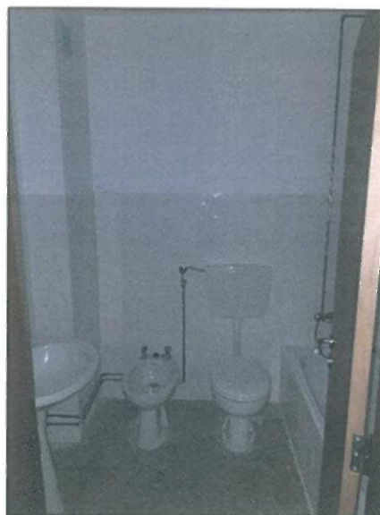
Figura 27 - HAB 263. Rua das Olarias, n.º 8, r/c, esq.ª
