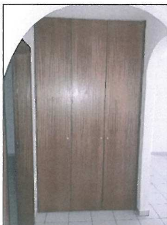
Figura 20 - HAB 620 – Rua Zulmira Lopes das Neves, nº9, r/c dt.º
