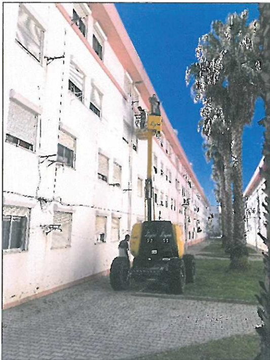
Figura 13 - Reparação de juntas de dilatação e rebocos soltos no Bairro da Rua Manuel de Oliveira
