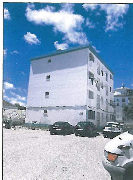
Figura 2 - Pintura exterior e substituição de estendais na Praça Alberto Lopes
