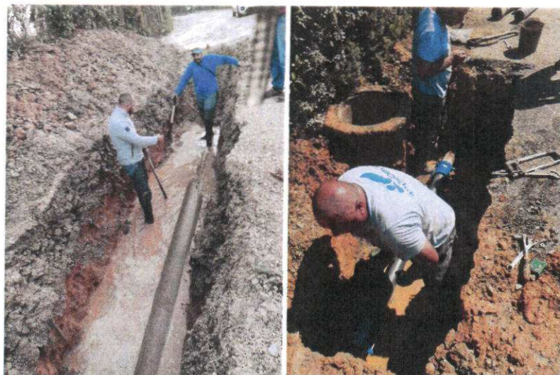
Figura: Reparações diversas realizadas nas infraestruturas de abastecimento de água
