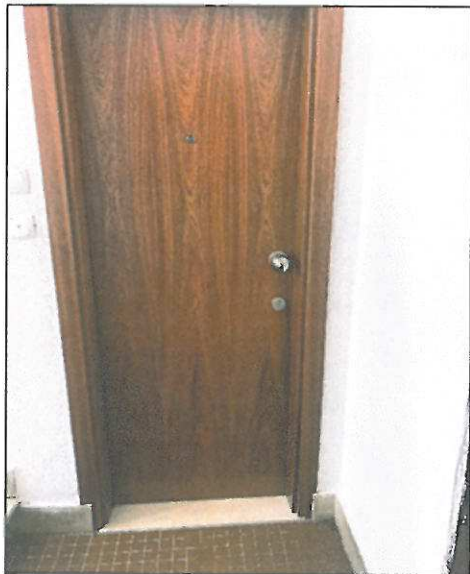
Figura 5 - Substituição das portas das habitações
