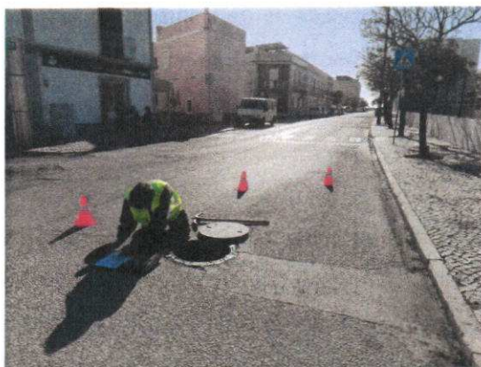
Figura: Trabalhos de inspeção visual dos coletores de drenagem de águas pluviais, na Rua Alberto Iria
