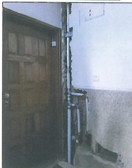
Figura 4 - Substituição das prumadas de águas
