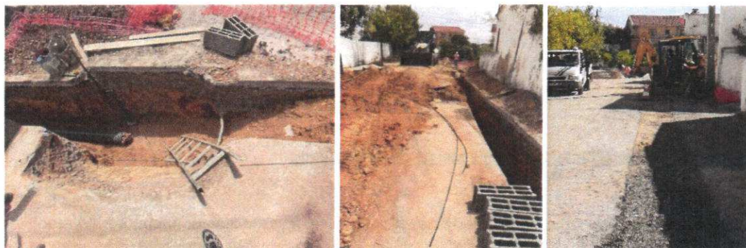
Figura: Vista dos trabalhos realizados na Rua das Olarias em Moncarapacho
