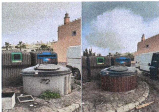
Figura: Reparação e requalificação de contentores semi-enterrados
