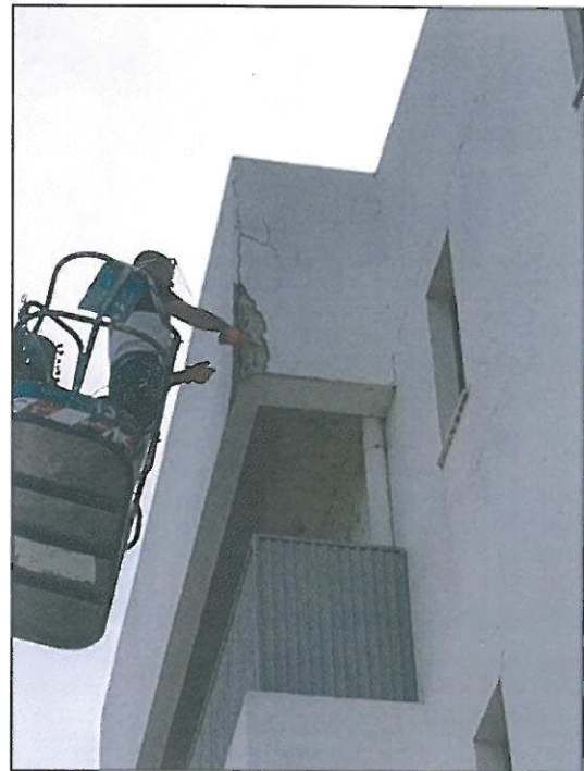
Figura 12 - Reparação de elementos de fachada em desagregação, Bairro da Largo da Feira.
