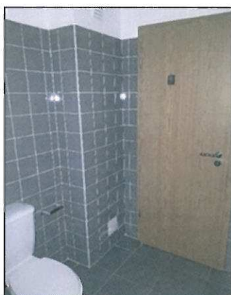
Figura 23 - HAB 820 – Rua da Armona, Edifício 1, bloco 4. r/c frente
