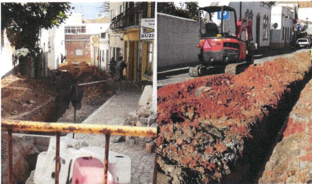
Figura: Obras de reabilitação da rede de abastecimento em Moncarapacho
