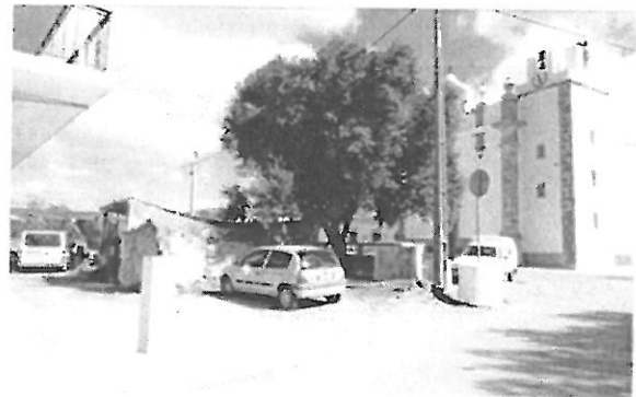
Vista parcial das construções pouco qualificadas que confrontam com o adro da igreja.
