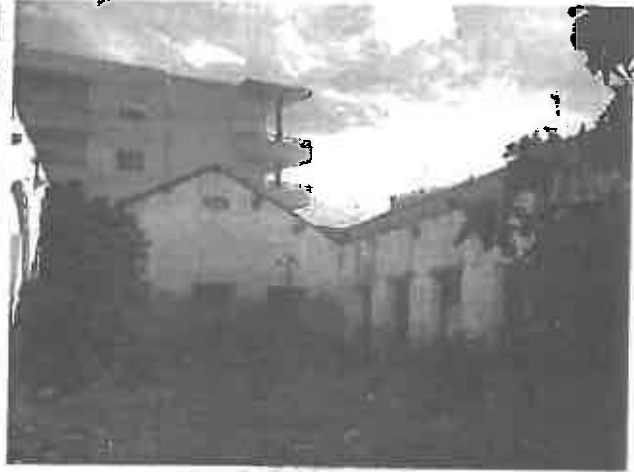
Foto 10 – Cobertura abatida. Acumulação de detritos. Proliferação de vegetação.
