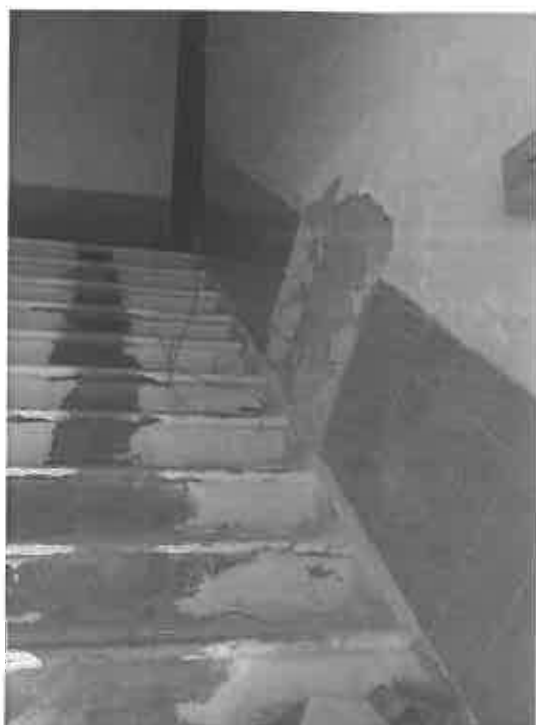
Foto 03 – Escada de acesso ao piso 1
