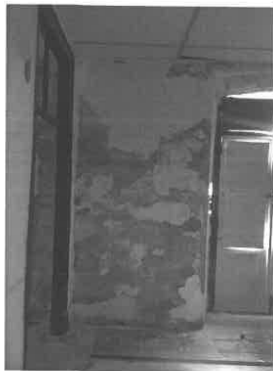
Foto 04 – Interior do piso 1
