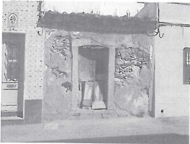
Foto 01 – Alçado principal do imóvel
