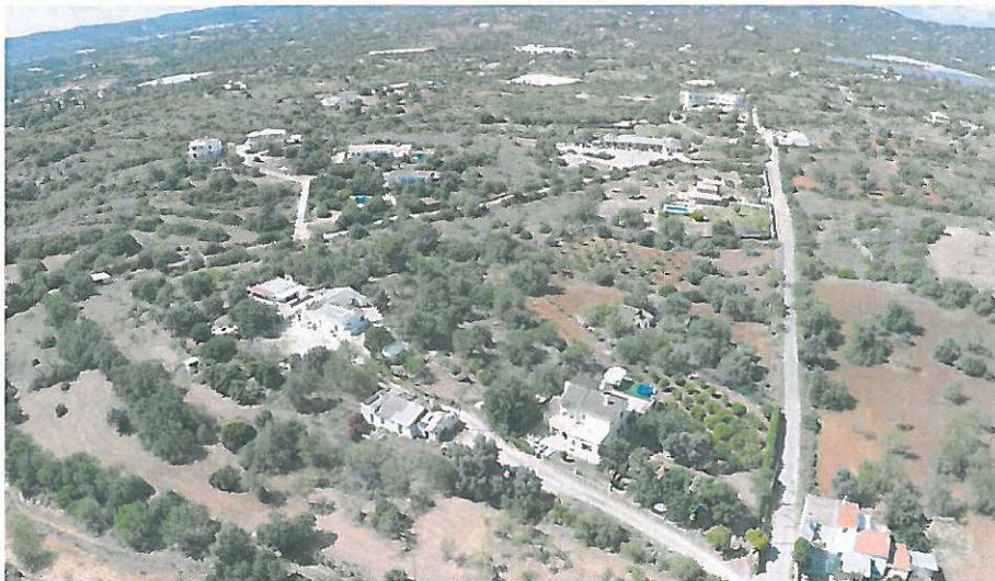
Fotografia 3 – Exemplo de edificações isoladas.
