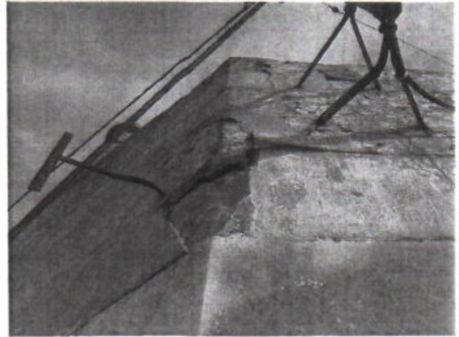
Foto 06 - Desprendimento de reboco nas paredes exteriores
