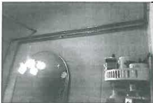
Figura 13- Substituição da rede de águas pelo exterior em aço inox, Praça Alberto Lopes, n.º 1, 1º dt.º.
