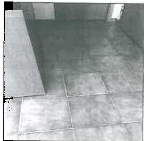
Figura 14- Reparação de pavimento, substituição de pavimento flutuante por pavimento cerâmico Loteamento Municipal da Atalaia, bl.12, r/c. esq.
