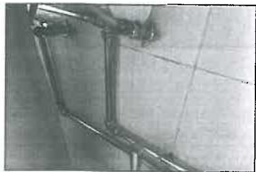
Figura 13- Substituição da rede de águas pelo exterior em aço inox, Praça Alberto Lopes, n.º 1, 1º dt.º.
