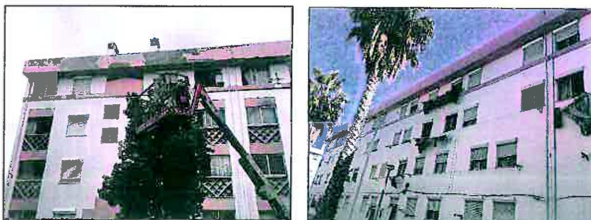
*Figura 5- Reparações pontuais das platibandas com argamassas reparadora.*
