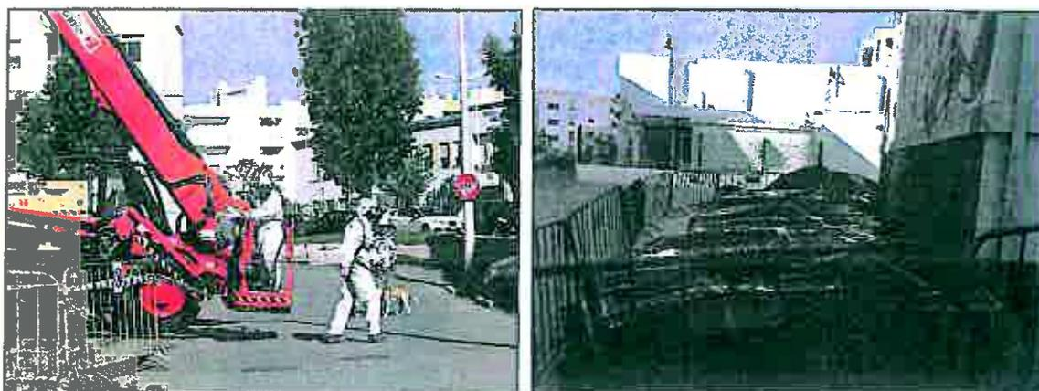
*Figura 4- Recolha das chapas de amianto e seu acondicionamento para transporte e destruição.*
