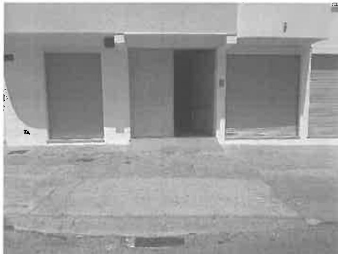
Portão do armazém
