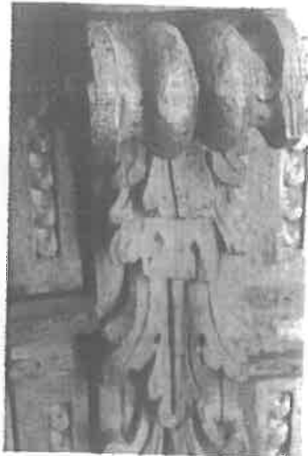
Img. 13 – Lacunas com o suporte à vista.
