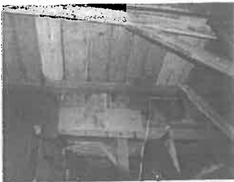
Img. 5 e 6 – Estado da degradação do suporte e deficientes tipos de ligações.
