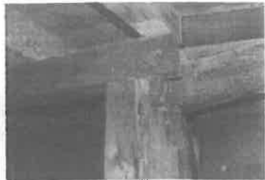
Img. 5 e 6 – Estado da degradação do suporte e deficientes tipos de ligações.
