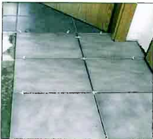
Figura 14- Reparação de pavimento, substituição de pavimento flutuante por pavimento cerâmico Loteamento Municipal da Atalaia, bl.12, r/c. esq.
