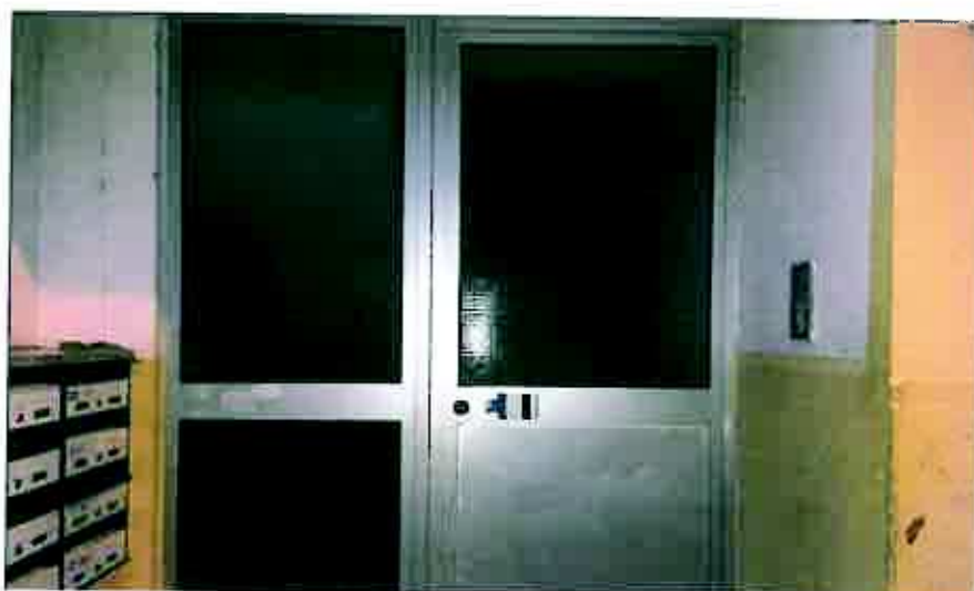
Figura 15- Substituição de vidros em zonas comuns, Horta Dr. Pádua, bloco 13
