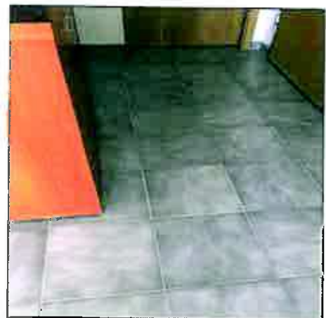
Figura 14- Reparação de pavimento, substituição de pavimento flutuante por pavimento cerâmico Loteamento Municipal da Atalaia, bl.12, r/c. esq.
