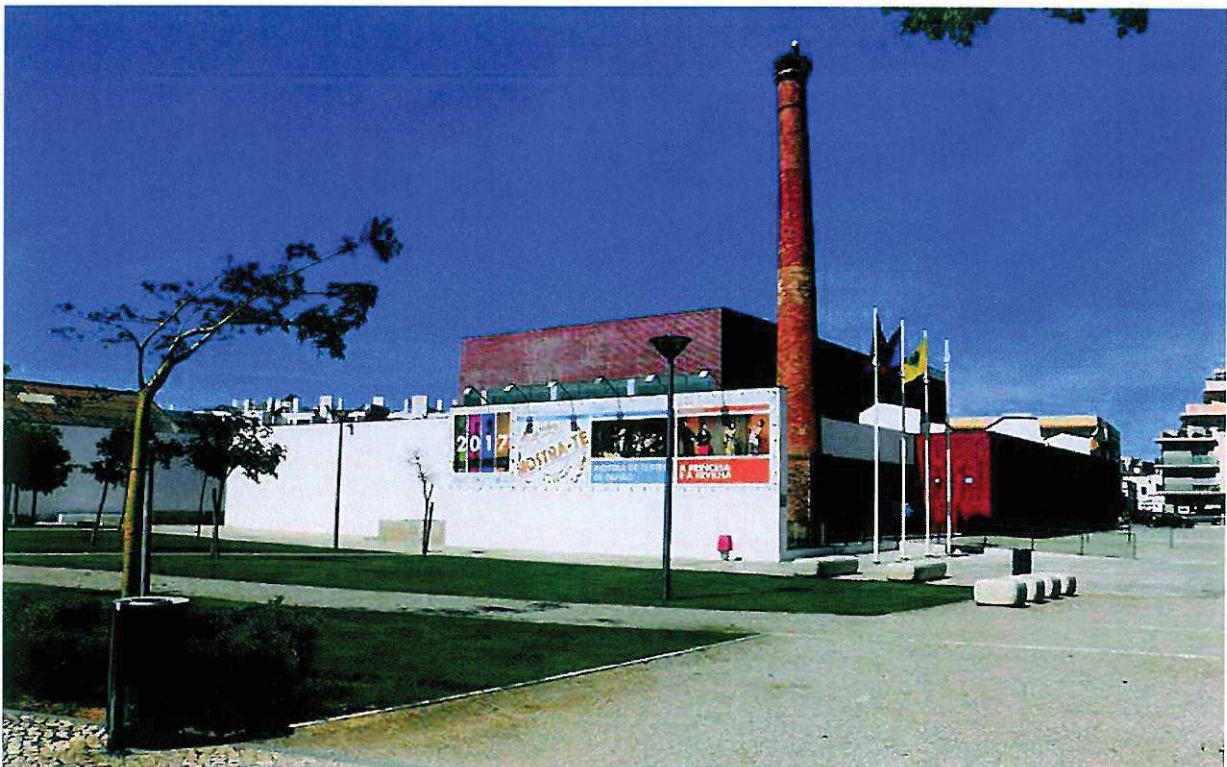
Figura 1- Auditório Municipal de Olhão (AMO)
