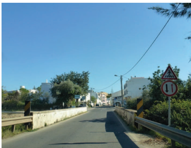
“Estrangulamento” da ponte existente à saída de Pechão
