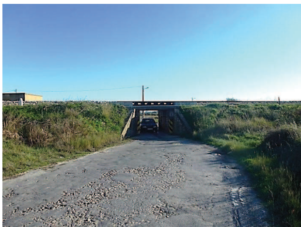
Passagem inferior da EM516-1 sob a Linha do Algarve
