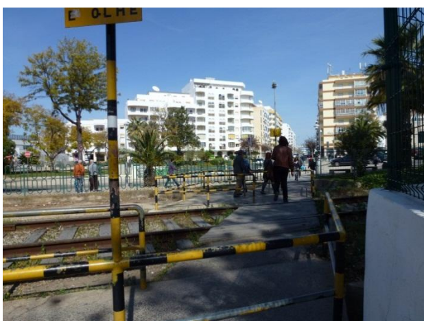
Passagem pedonal na Linha Ferroviária do Algarve (Avenida da República)
