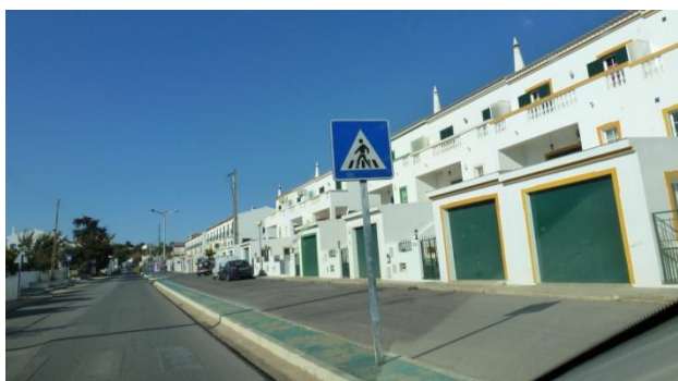
Sede da freguesia de Quelfes (zona Q.03)
