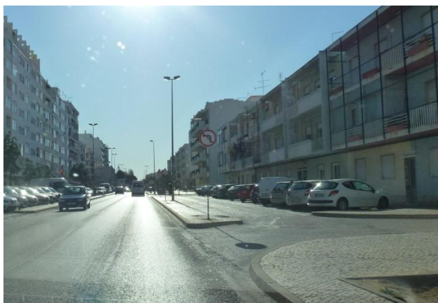
Bolsas de estacionamento isolado ao longo da EN125
