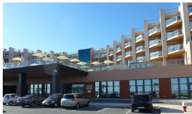
Real Marina Hotel & Spa, na zona Ribeirinha de Olhão (zona O.03)
