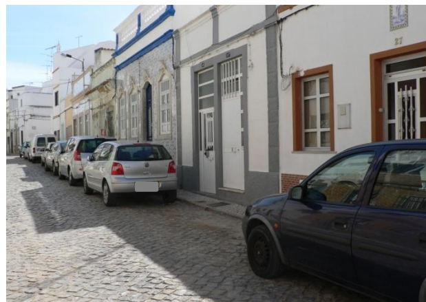
Dimensões reduzidas ou “inexistentes” dos passeios no centro de Olhão
