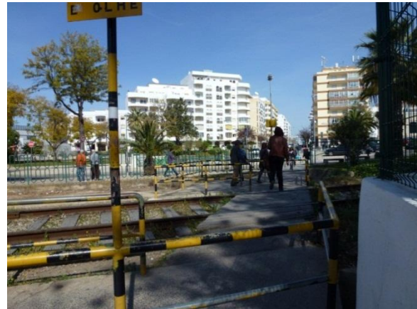
Passagem pedonal na Linha Ferroviária do Algarve (Av. da República)
