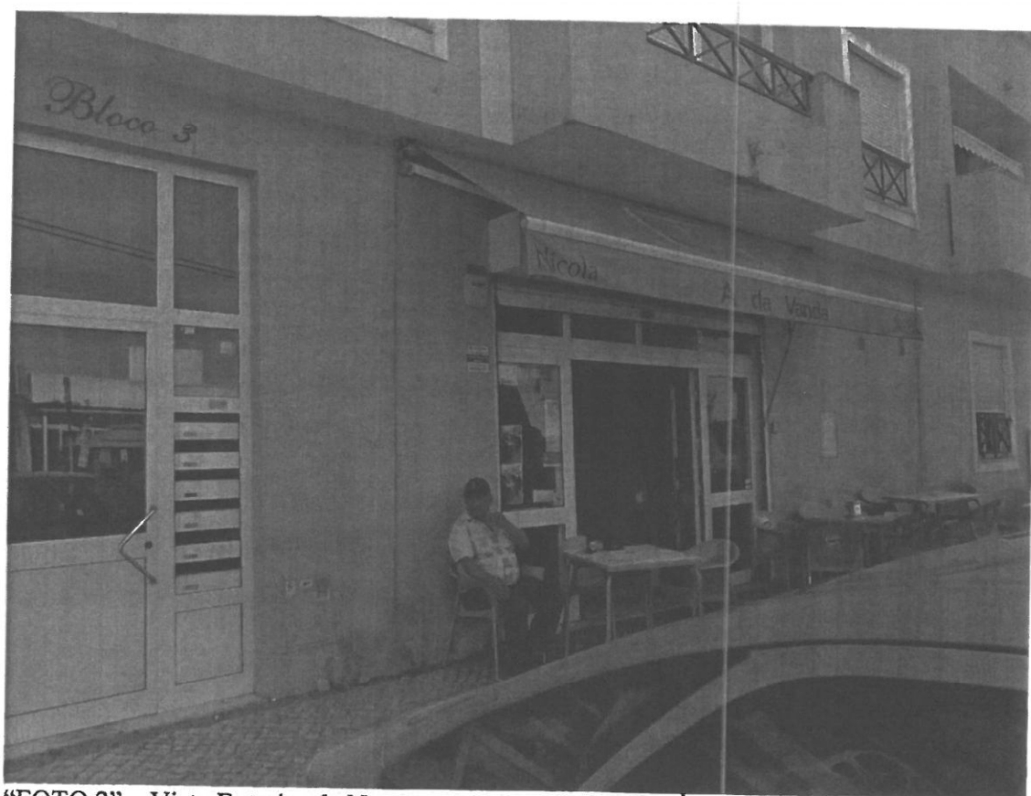
"FOTO 2" – Vista Exterior de Norte para Sul, para o Café "À da Vanda" Pechão - Olhão.
