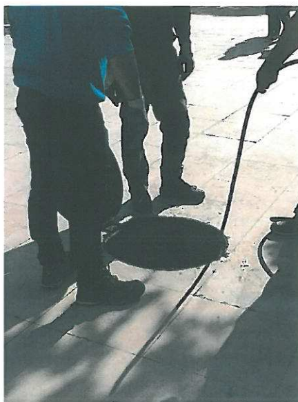
Fig. 7 – Limpeza de caixa de visita de águas pluviais.
