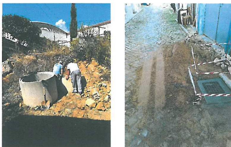
Fig. 4 e 5 – Manutenção de coletores e de ramais pluviais.
