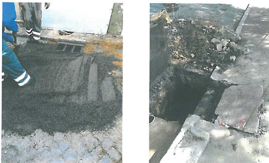
Fig. 12 e 13 – Construção de sumidouro e reabilitação de uma sarjeta.
