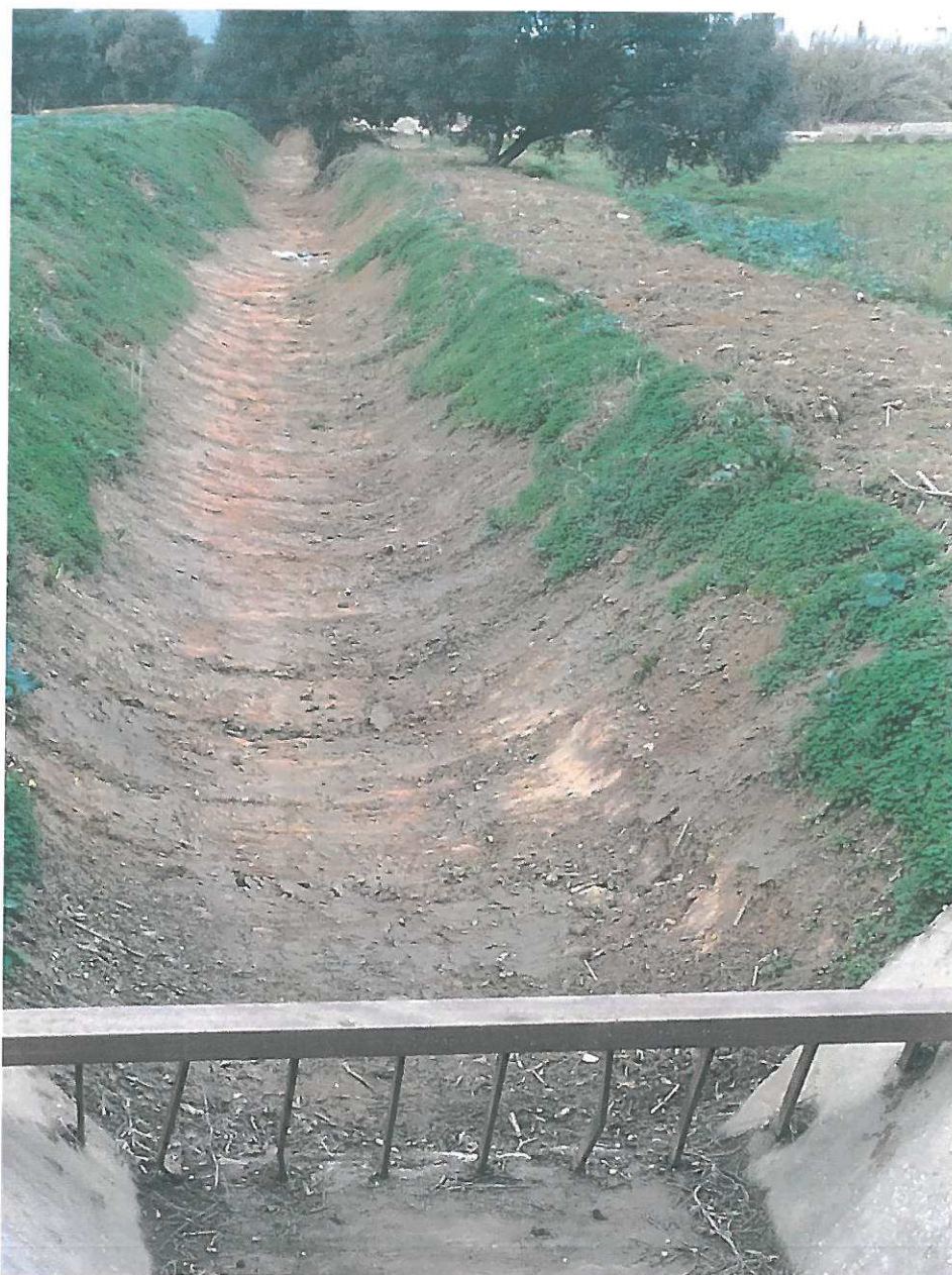
Figura 6: Aspeto geral do Ribeiro do Brejo após limpeza.
