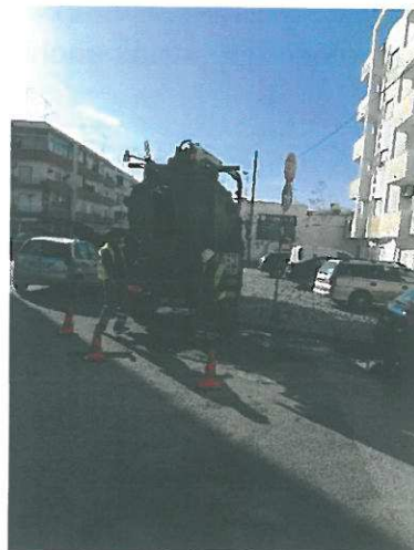
Fig. 1 e 2 – Carrinha para transporte dos colaboradores/material e viatura combinada (limpa-fossas) a realizar limpeza de coletores.
