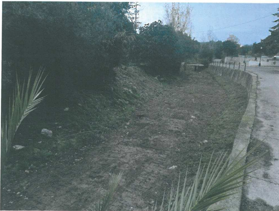
Figura 13: Ribeira de Belamandil (dentro de Pechão) depois da limpeza e desmatagem.
