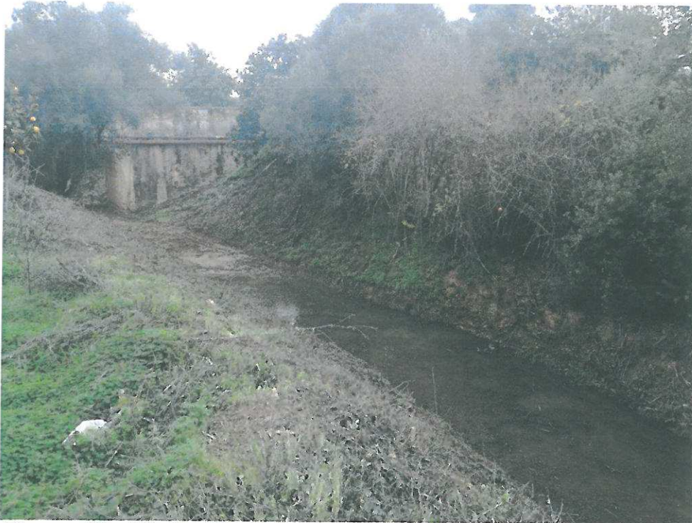
Figura 12: Ribeira de Belamandil (dentro de Pechão) depois da limpeza e desmatagem.
