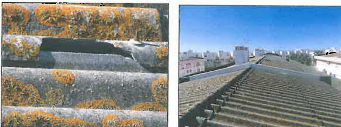
*Figura 3- Substituição das coberturas em telhas de fibrocimento por telhas do tipo “sandwich” e reparação dos elementos soltos das platibandas.*
