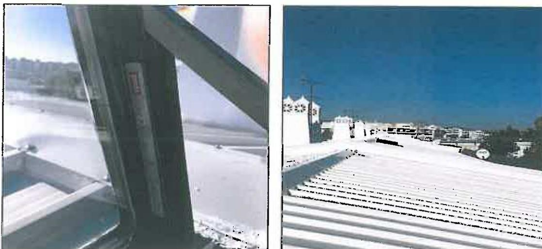
Figura 6- Painéis sandwich e substituição de claraboias.
