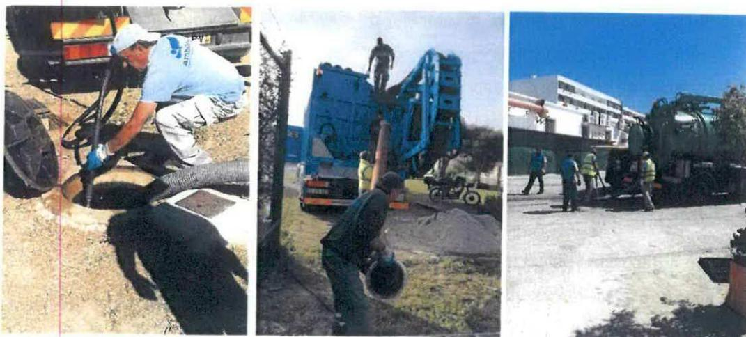
*Limpeza e desobstrução de caixa de vista de coletor de águas residuais (esquerda). Desobstrução de coletores e limpeza de inertes com meios mecânicos (centro e direita).*
